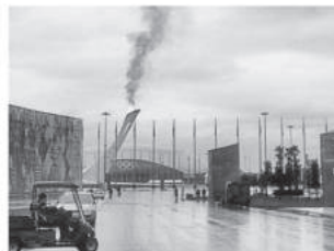
Идет наладка оборудования
