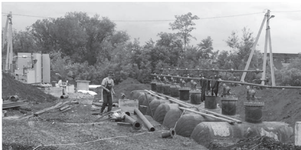
Рис. 6.3. Перспективным направлением развития смесительных систем в России является их применение в качестве источника дополнительного газоснабжения для покрытия пиковых нагрузок. Устройство парка хранения СУГ часто обходится значительно дешевле, чем перекладка существующего газопровода на больший диаметр
